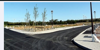
Un nouveau lotissement
